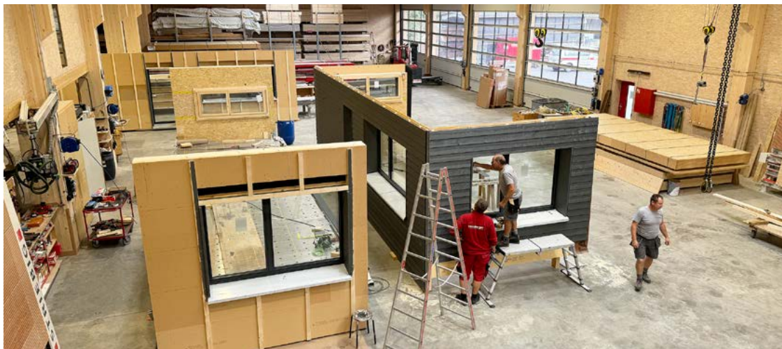
Blick in die Werkhalle «Woodfactory», wo die Anbauten für die Kindergärten Gländ, Oberfeld und Kirchacker vorgefertigt werden.
